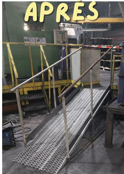
Amélioration d'un poste de travail à l'usinage en remplaçant des escaliers par une rampe ce qui nous apporte plusieurs avantages, notamment en termes d'accessibilité, de sécurité et d'ergonomie.
